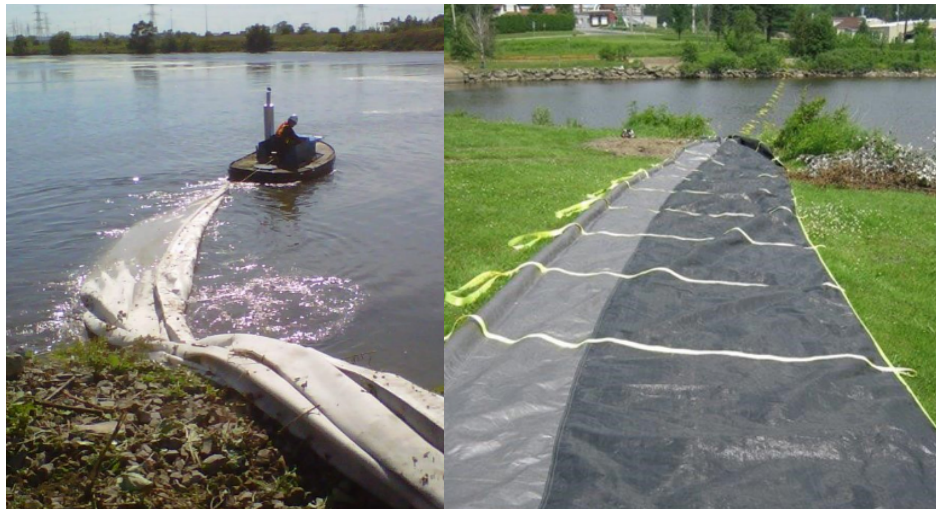
Figure 1 – Rideau de turbidité Tirée de Soleno (2019)
